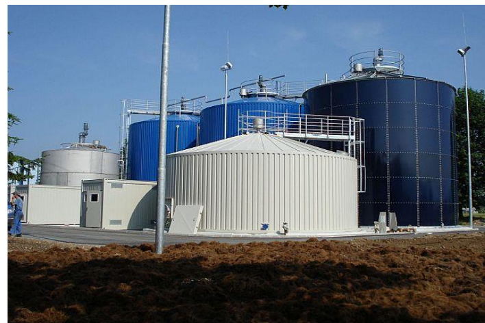
Биогазовый комплекс «Рассвет», 4,8 МВт, Могилевская обл.
