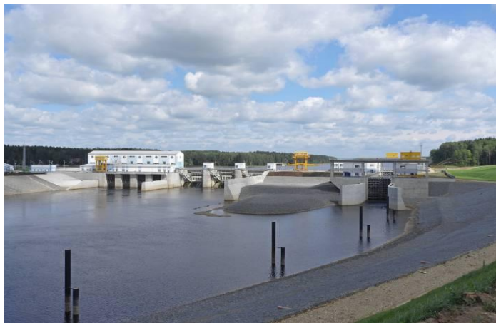
Витебская ГЭС 40 МВт
